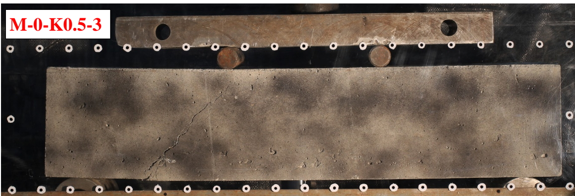
4.31. ábra: 0,5 V% kampós végű acélszál erősítésű, kengyelek nélküli vasbeton gerenda próbatestek tönkremenetel utáni repedésképe
