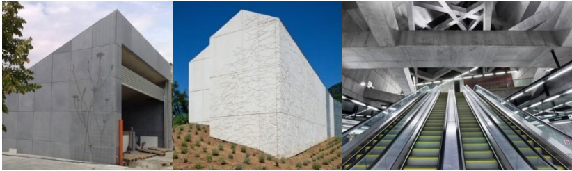
1. ábra: Látszóbeton felületek: a) Tétényi úti metróállomás, Budapest [1], b) Laposa Borászat, Badacsonytomaj [2], c) Fővám téri metróállomás, Budapest [3]
